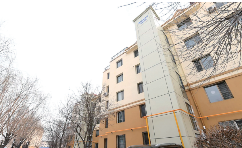
包头市老旧小区加装电梯改造 于水 摄
