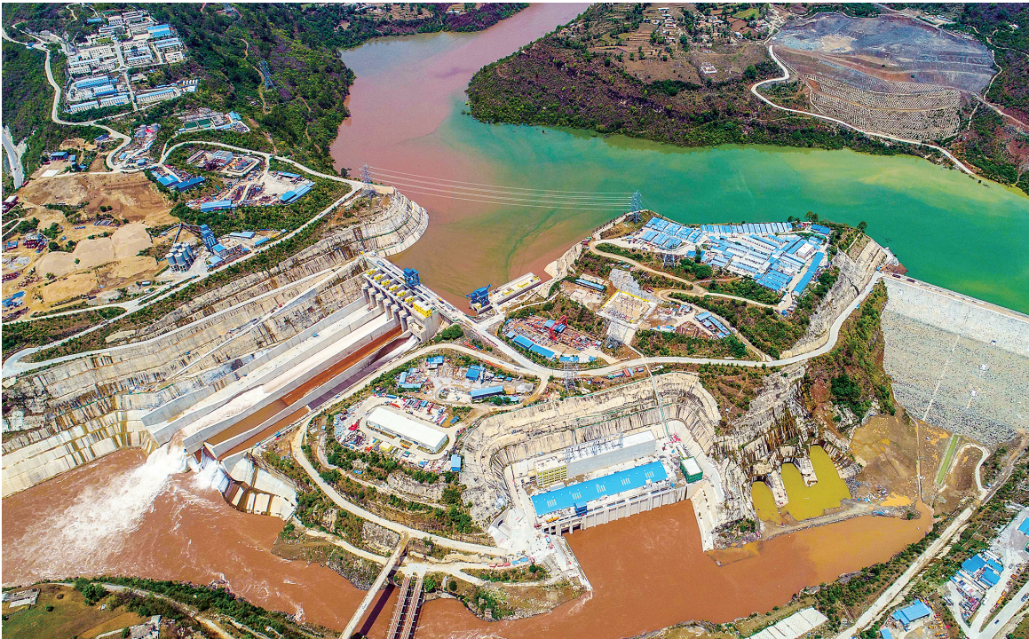
由中国三峡集团为主投资开发的中巴经济走廊首个水电投资项目——巴基斯坦卡洛特水电站
