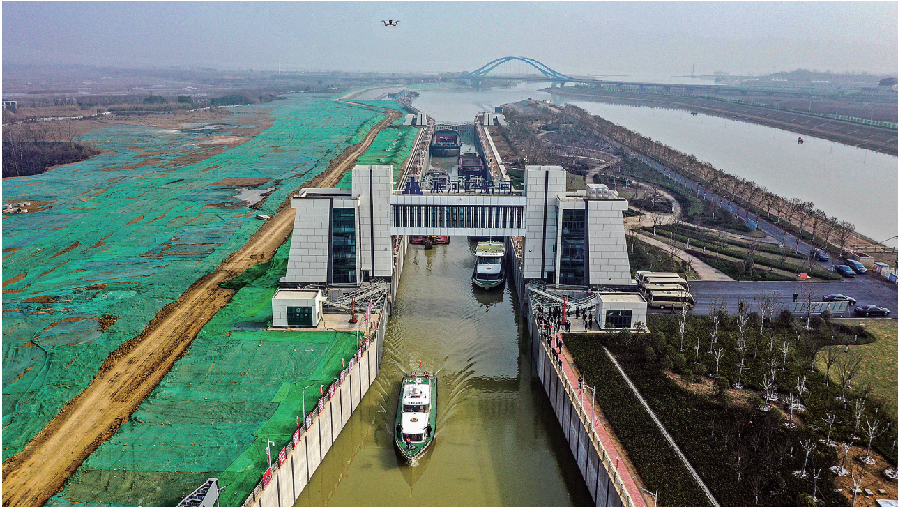
引江济淮工程是我国172项节水供水重大水利工程之一。2万余名工程建设者历经6年奋战,长江与淮河实现历史性“牵手”。工程供水范围涉及皖豫两省15个市55个县(市、区),输水线路总长723公里,受益范围7.06万平方公里,惠及皖北、豫东5000多万人口。图为船只通过引江济淮派河口船闸。
