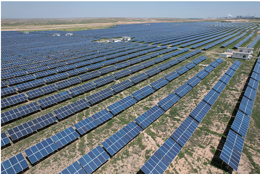
国华四道泉光伏电站
