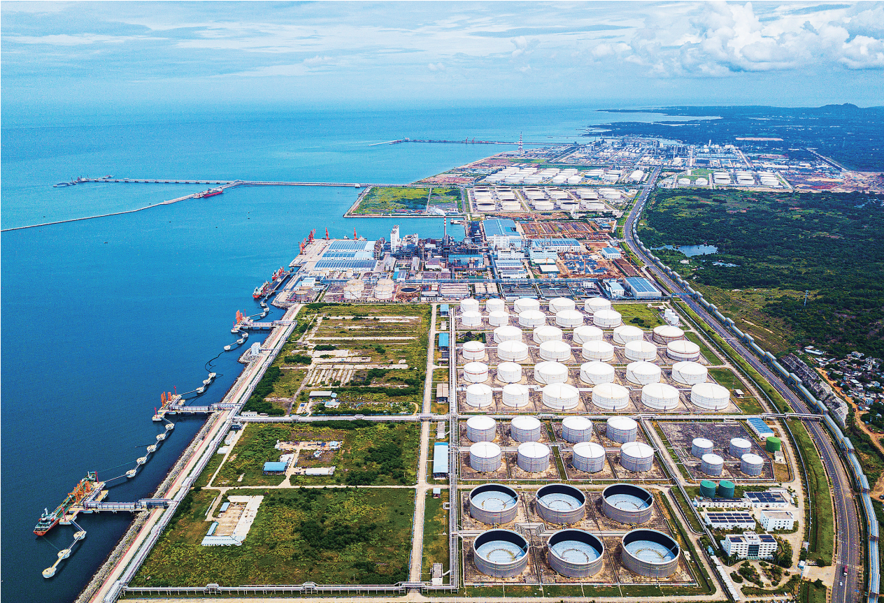
《海南自由贸易港建设总体方案》实施两年多来,企业对投资海南自由贸易港热情高涨,市场主体迅速增加。近两年新增市场主体超过100万户,增速连续28个月保持全国第一。截至今年8月底,存续市场主体已突破200万户。图为今年10月拍摄的海南自贸港重点园区——洋浦经济开发区众多工业企业。(资料图片)
