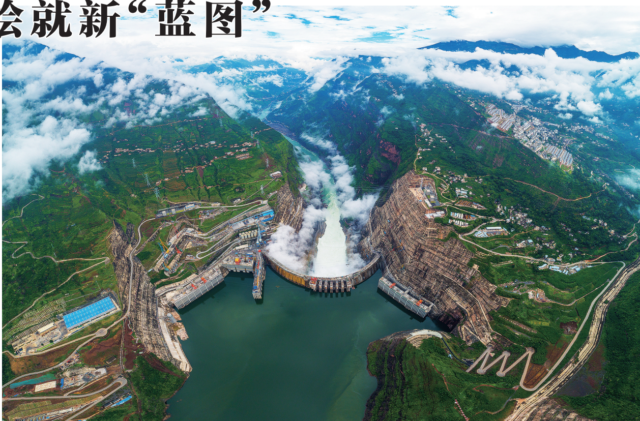
白鹤滩水电站是在建规模世界第一的巨型水电工程,是金沙江下游四个水电梯级中的第二个梯级。白鹤滩水电站开发任务以发电为主,兼顾防洪、航运,并促进地方经济社会发展。图为航拍白鹤滩水电站全景观貌。
