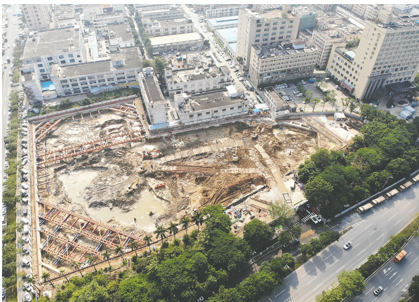
图为茅洲河体育艺术中心(上村文体中心)施工现场照
