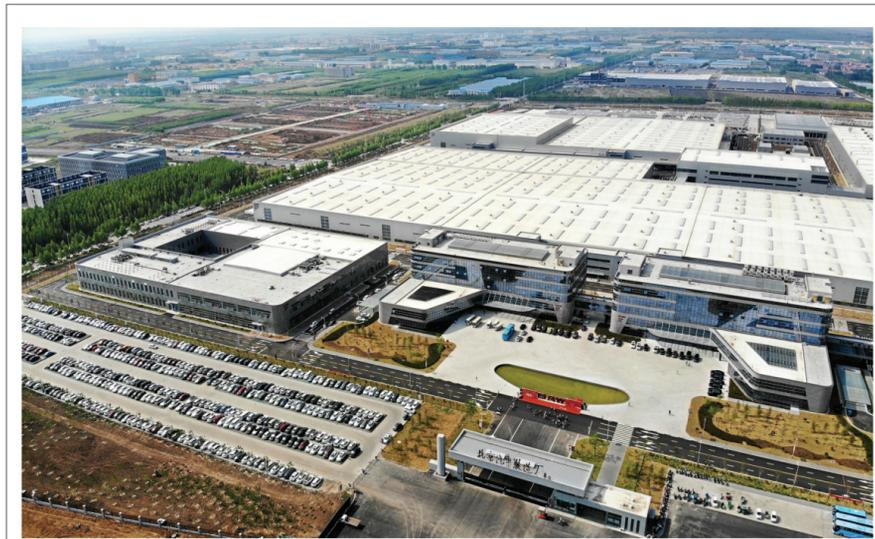
北京汽车制造厂青岛总部基地项目于2020年开工建设，并于2022年1月竣工投产。该项目位于青岛莱西姜山镇，主要建有总部办公大楼、研究总院大楼、国家级研发实验中心、冲压车间、焊装车间、涂装车间、总装车间、改装车间、动力中心、仓储物流中心等设施，四大工艺车间的生产自动化率均达到国内领先水平。
