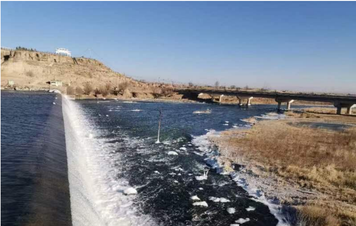
永定河大同段河道
