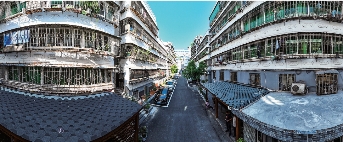
北城街道大通门社区仿古街小区A、D栋改造完工
