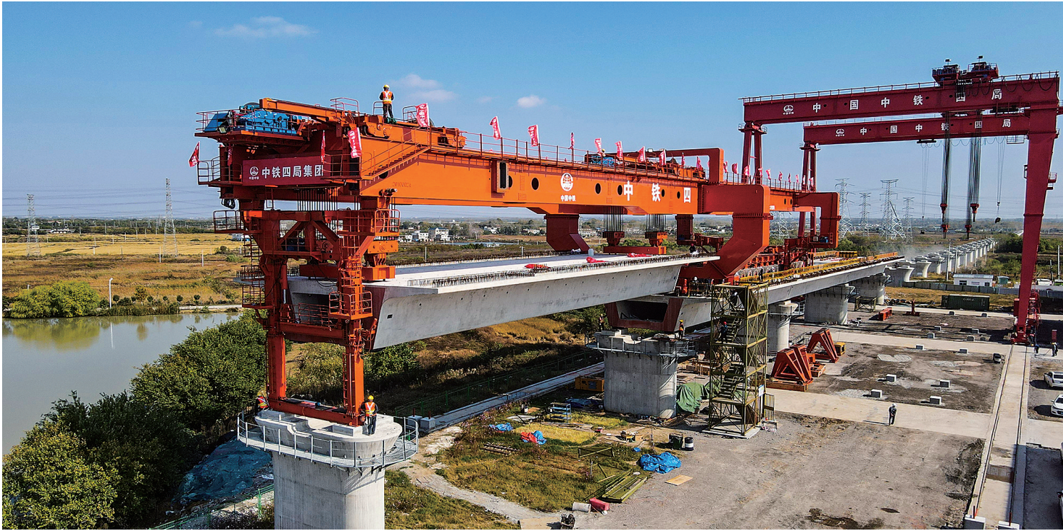
合新铁路架梁忙
