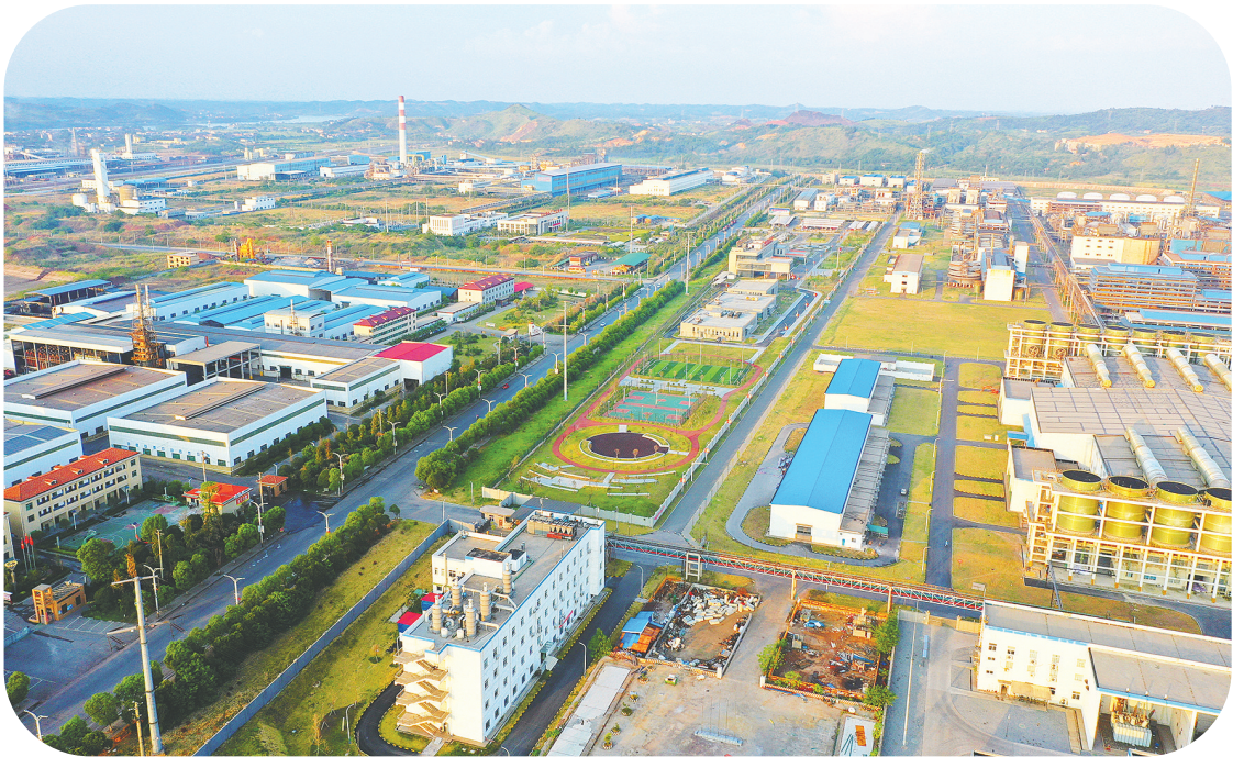
水口山工业园区俯瞰图
