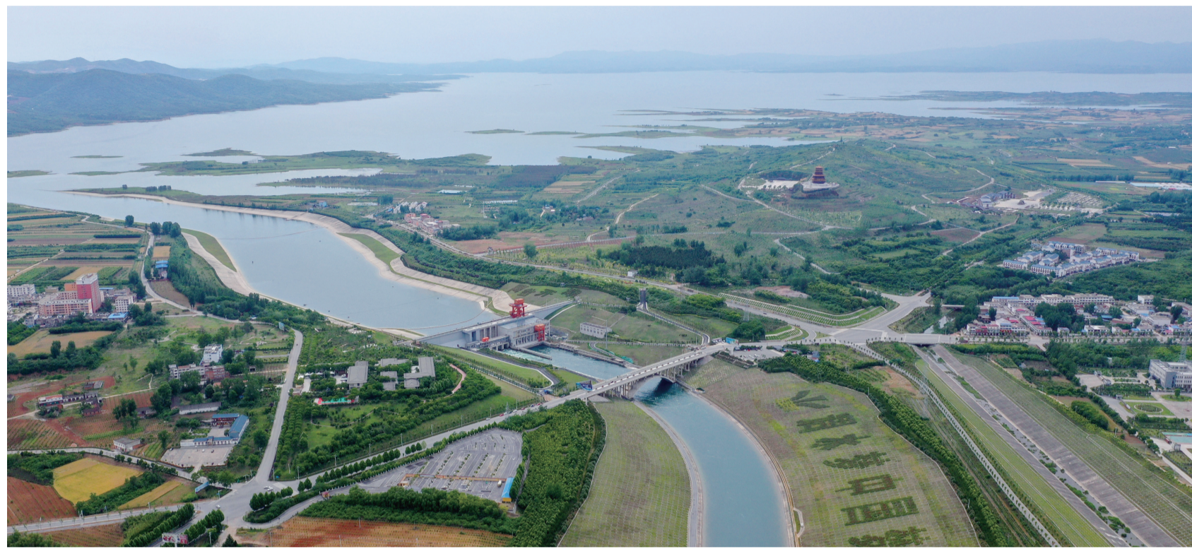
南水北调工程是一项宏伟的生态工程和民生工程，发挥了显著的经济、社会和生态效益。图为位于河南省淅川县的南水北调中线工程陶岔渠首。
