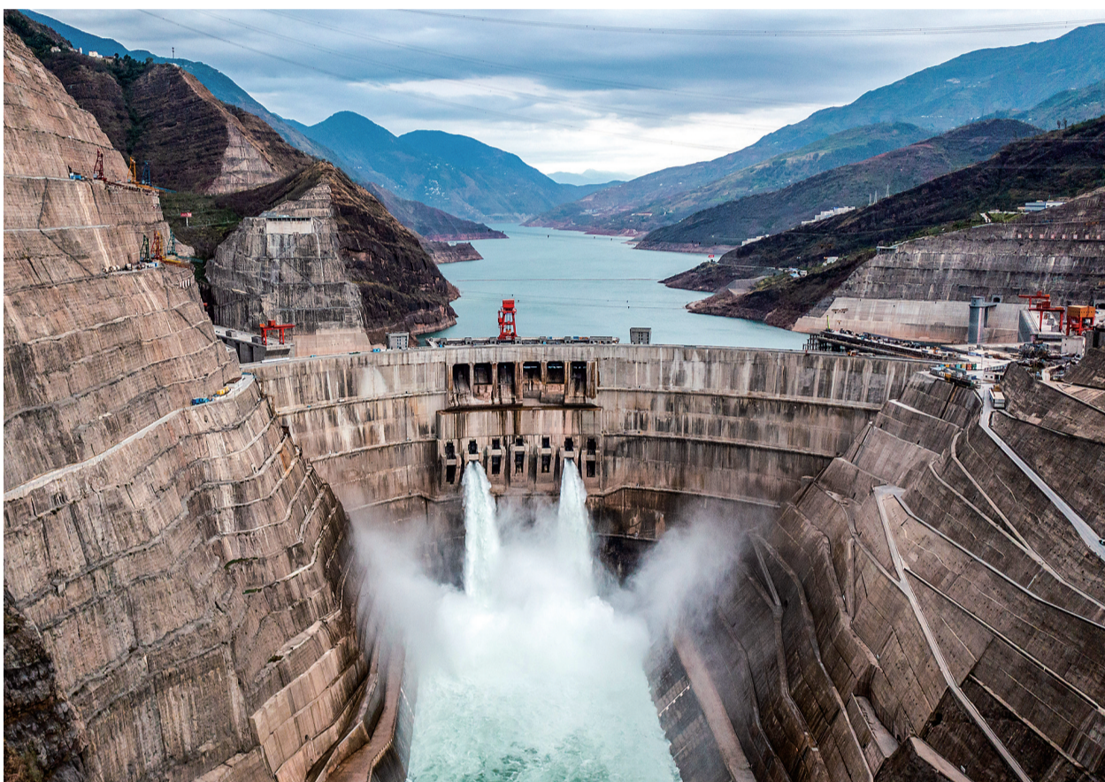
白鹤滩水电站位于四川省宁南县和云南省巧家县交界处金沙江干流河段上,是实施“西电东送”的国家重大工程,总装机容量1600万千瓦。
