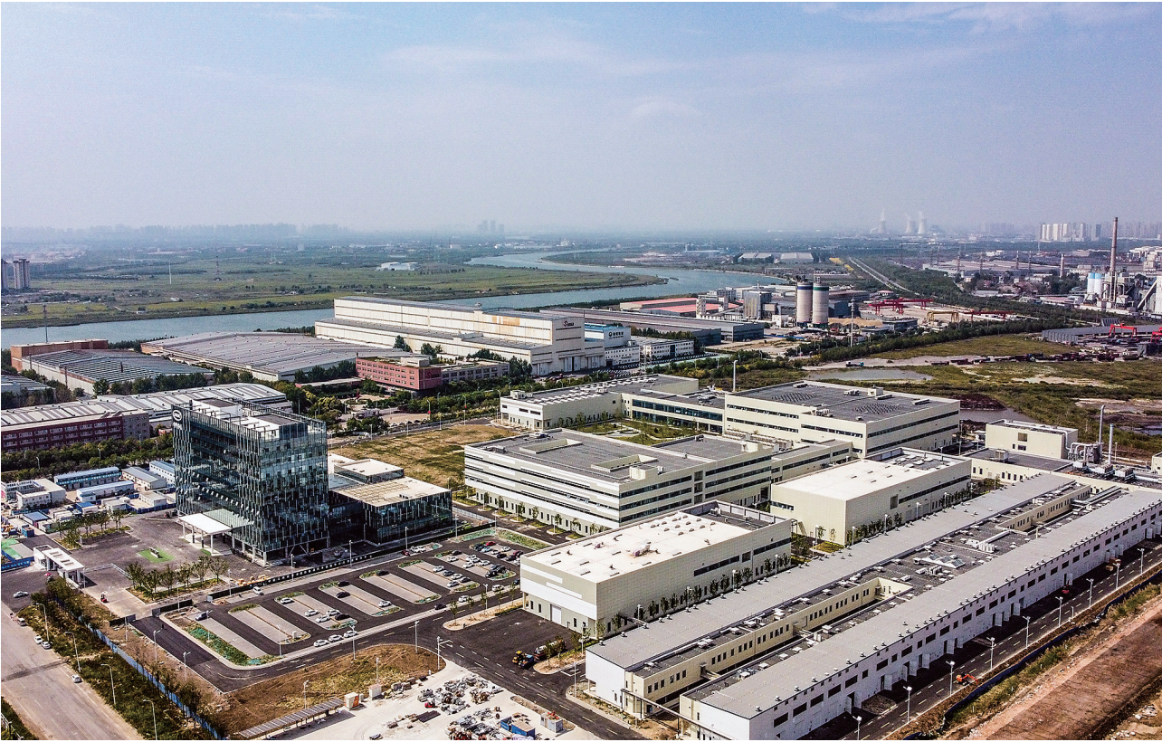
近日，中国汽车技术研究中心有限公司新能源汽车科技创新基地在天津建成启用。该基地共建设11.6万平方米的综合试验楼，配套超过1000台套测试设备，主要围绕燃料电池、动力电池、电驱电控、充电技术、电磁兼容、新能源整车等六大领域，测试能力覆盖新能源乘用车、商用车整车和其他相关部件。图为中汽中心新能源汽车科技创新基地外景。
