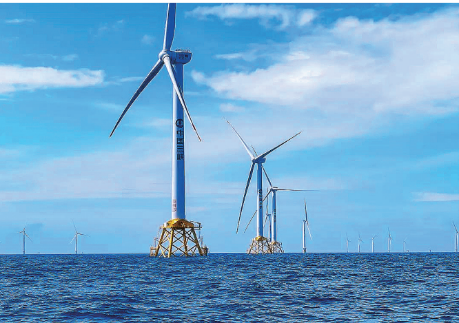
东方风电阳江项目43台7MW海上风电机组
