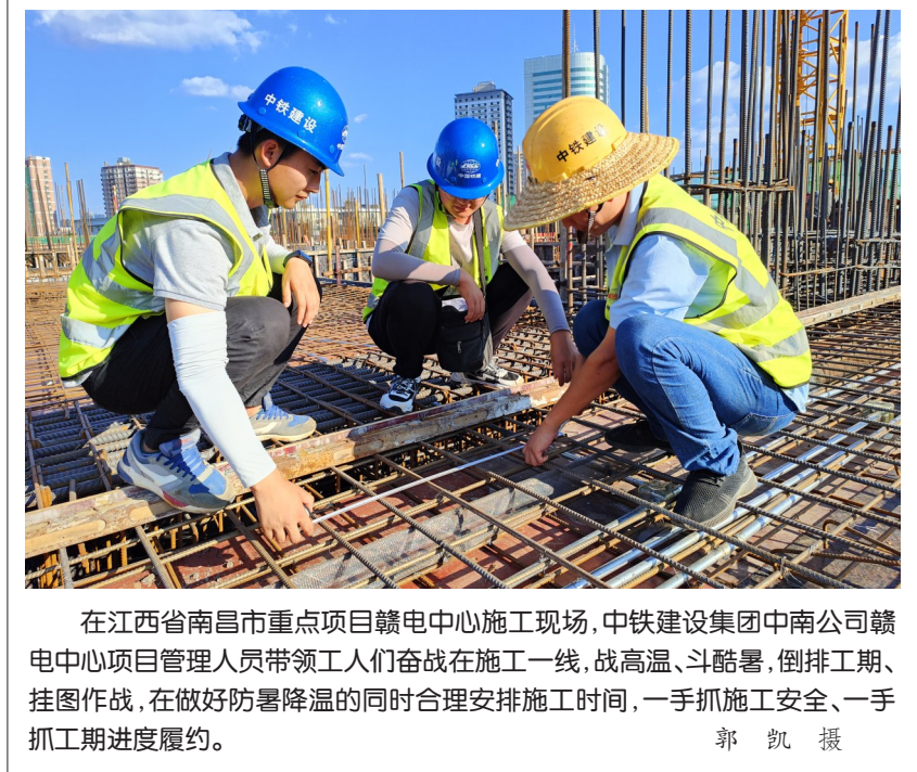
在江西省南昌市重点项目赣电中心施工现场,中铁建设集团中南公司赣电中心项目管理人员带领工人们奋战在施工一线,战高温、斗酷暑,倒排工期、挂图作战,在做好防暑降温的同时合理安排施工时间,一手抓施工安全、一手抓工期进度履约。 郭凯摄
