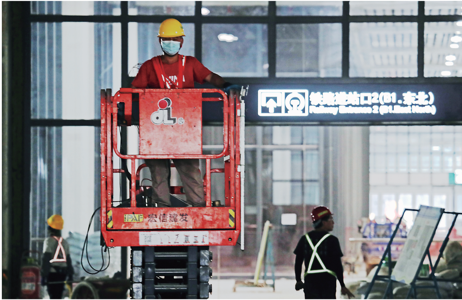
目前，广西南宁国际空港综合交通枢纽工程进入施工收尾阶段，预计2022年9月实现整体竣工验收。广西南宁国际空港综合交通枢纽工程是广西首个集民航、城际铁路、公路、城市轨道交通、城市公交、出租车及社会停车等功能于一体的综合交通枢纽。建成后，将实现公路、城际铁路、轨道交通、城市公交、出租车等多种交通方式立体换乘。图为8月17日，工人在施工现场进行装饰作业。
