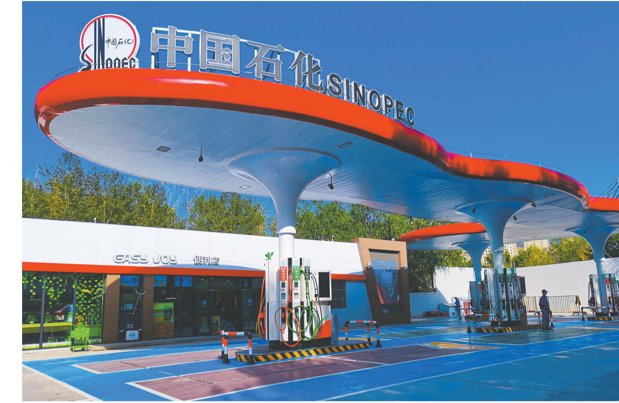
图为中国石化青海石油祁连路加油站
