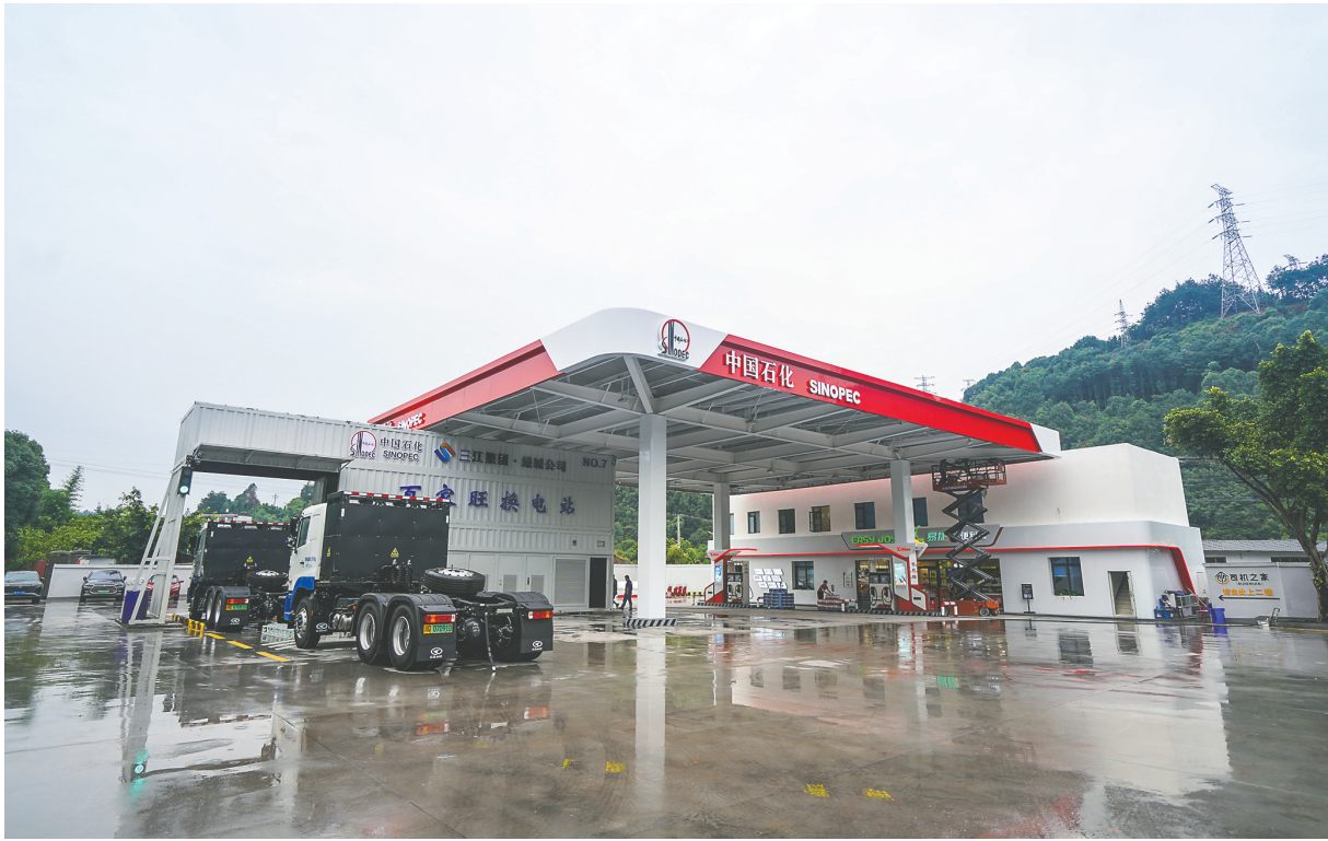
7月20日,中国石化首座重卡换电站——百家旺综合加能站在四川宜宾建成投用,自动实现车辆“满电复活”仅需3分钟。
