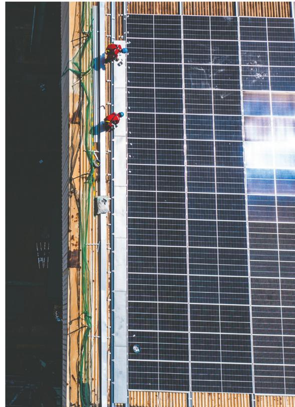
6月29日,浙江舟山长宏国际船舶修造有限公司(以下简称“长宏国际”)屋顶分布式光伏项目正式投运,这也是浙江省最大的“不拆瓦”建筑光伏一体化项目。据了解,该项目涉及长宏国际6个厂房屋顶,约20万平方米,累计安装光伏组件35,354块,总装机容量为19,267.93千瓦,采用“自发自用,余电上网”的方式向舟山电网系统上送功率,并网运行后发电量预计达1883万度。“不拆瓦”建筑光伏一体化是针对老旧厂房屋顶拆除费用高昂的问题创新研发的施工工艺,在有效节省安装成本的基础上,提升建筑光伏一体化项目整体经济性、适用性,带动海岛企业共同参与光伏建设的积极性,推进绿色能源产业升级。图为工作人员在长宏国际屋顶巡检刚刚投运的分布式光伏项目设备。
