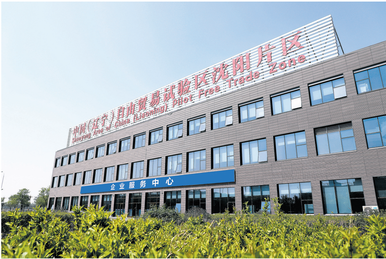
辽宁自贸试验区沈阳片区企业服务中心
