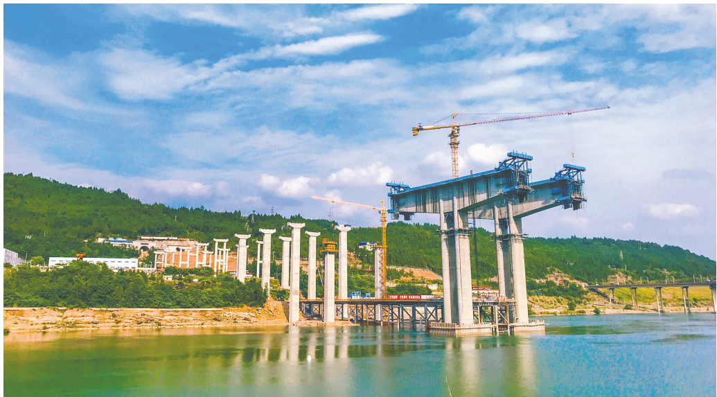
广元市苍溪县境内正在修建的成绵苍巴高速嘉陵江特大桥
