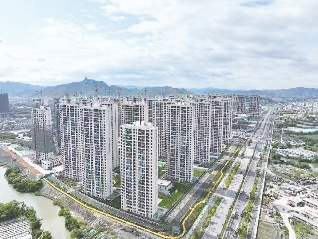
浙江省温岭市横峰街道全域改造R25-1安置小区(湖悦华庭),2022年4月11日顺利通过竣工验收,共有2148套安置房,计划5月底开展村民选房抽签,交付使用。(温岭改革办供图)
