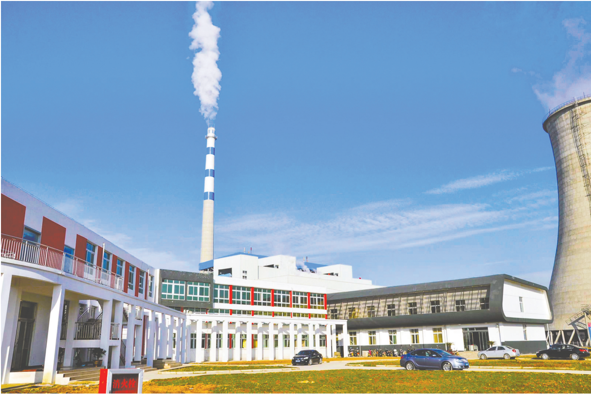
大唐邓州生物质能2*15MW热电机组
