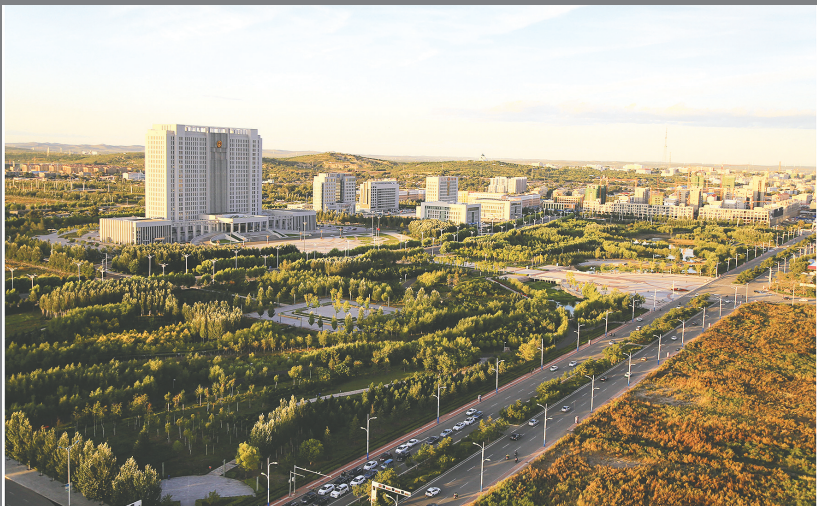
建设中的乌兰浩特市新区生机盎然
