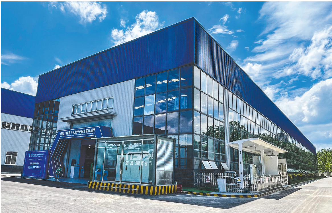
位于贵州省贵阳市的全球首批单机100kW质子交换膜燃料电池热电联产项目，以燃料电池热电联供系统在产业园区内提供部分热能及电力为实施目标，为广泛应用提供设计及建设经验，为未来的终端用户提供体验场景。该项目燃料电池模块由贵州氢能效率能源科技有限公司提供，项目采取热电联产设备为固定式发电场景专用设备，运行寿命可达40,000小时。
