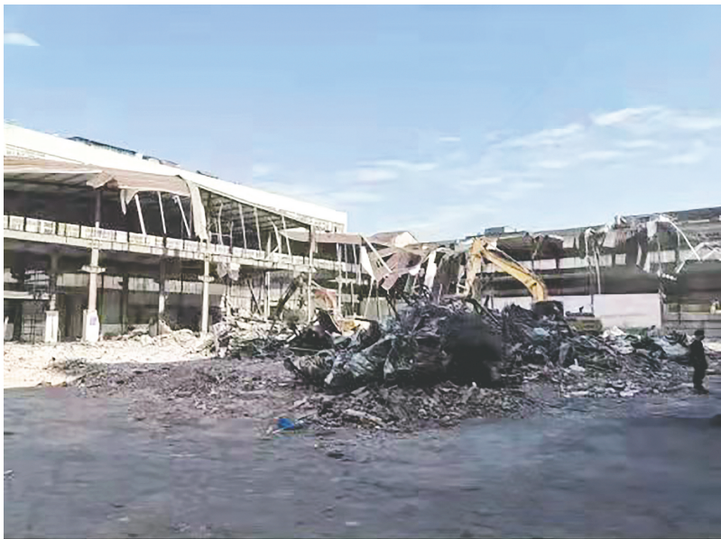
正光阀门“零地”改造进行中
