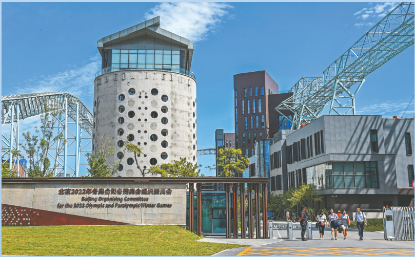
北京2022年冬奥会和冬残奥会组委会办公区西门入口处（首钢新闻中心供图）
