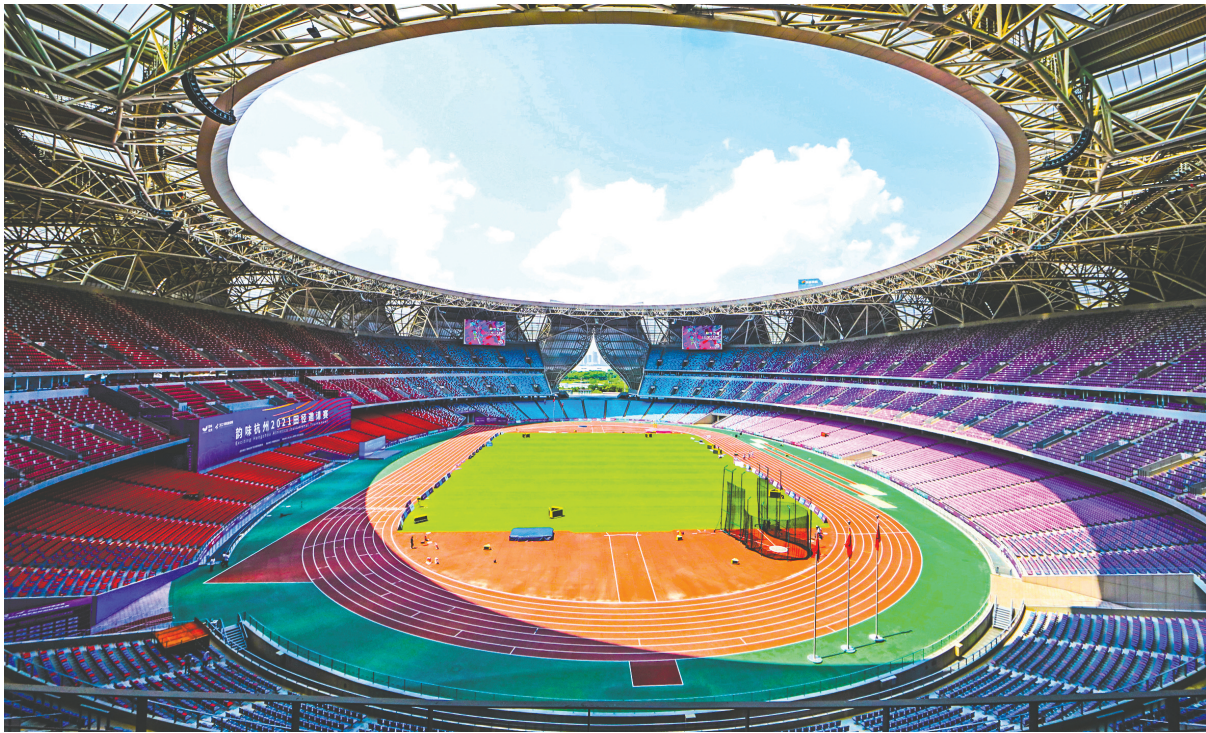
杭州奥体中心体育场内景
