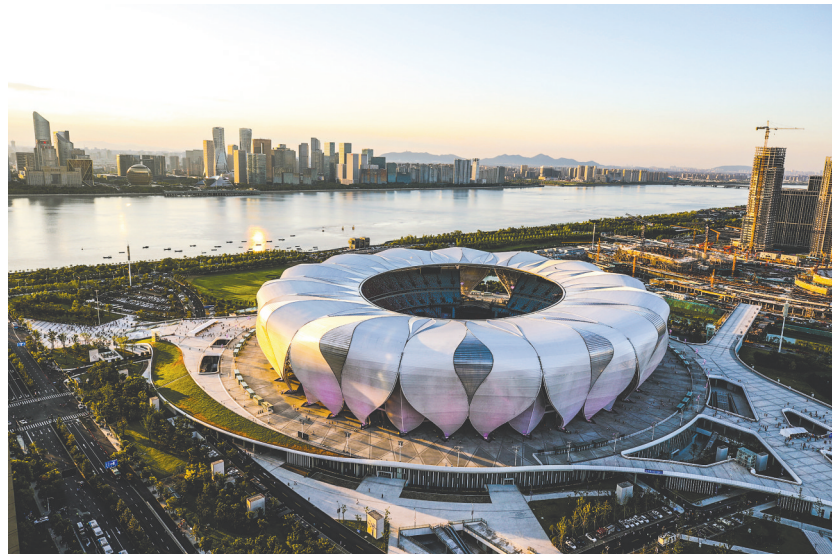
杭州奥体中心体育场
