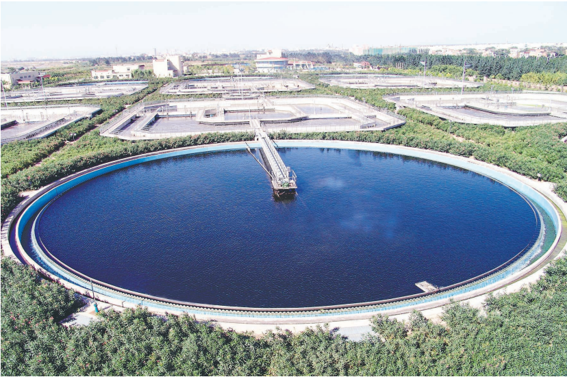
洛阳瀍东污水处理厂全景
