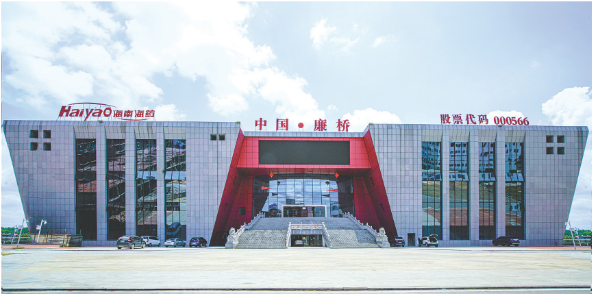
廉桥镇中药材专业市场会展中心
