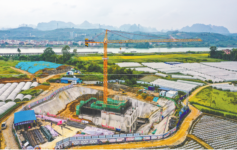
百色水库灌区是国务院172项节水供水重大水利工程之一，项目建成后可有效发挥百色水利枢纽的综合效益。图为百色水库灌区的林逢泵站主体工程施工现场。
