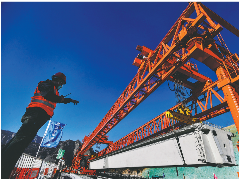
国道109新线高速龙王沟2号大桥施工现场 (北京市政路桥股份有限公司工程总承包二部提供)
