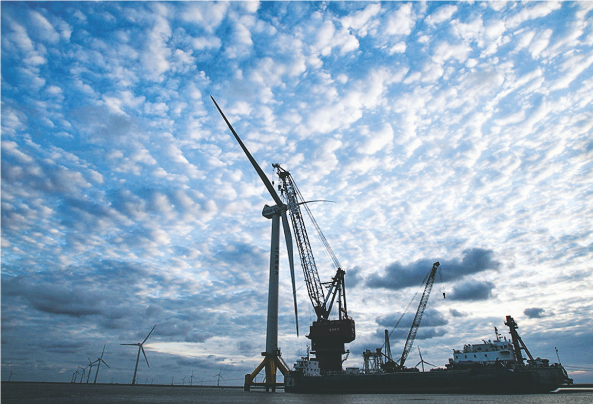
江苏如东八仙角300兆瓦海上风电项目(资料图片)
