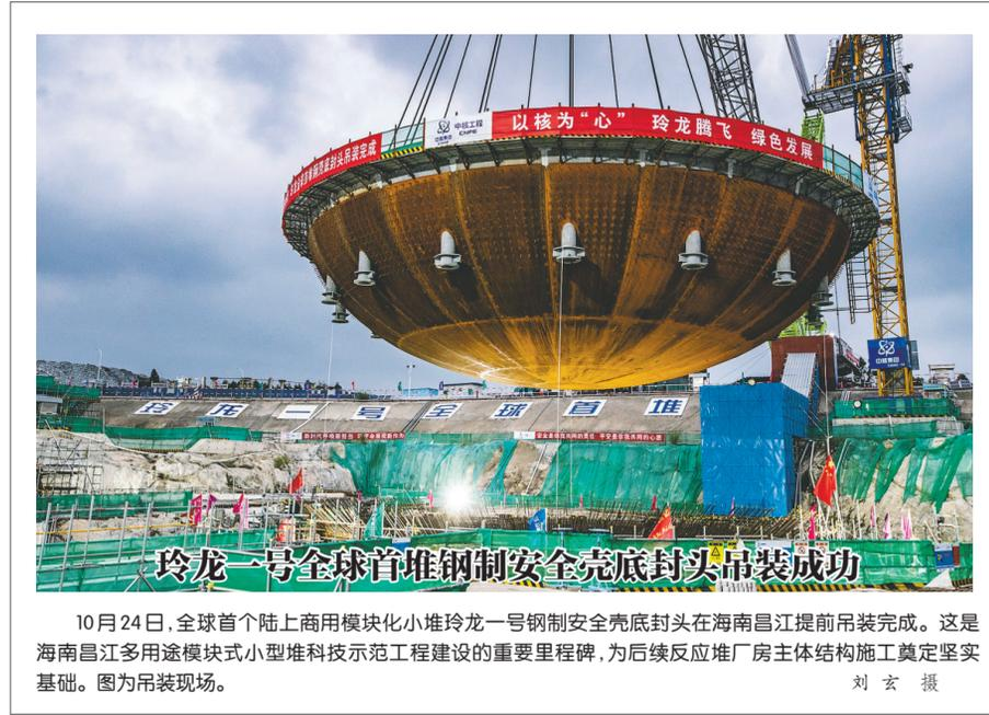
10月24日,全球首个陆上商用模块化小堆玲龙一号钢制安全壳底封头在海南昌江提前吊装完成。这是海南昌江多用途模块化小型堆科技示范工程建设的重要里程碑,为后续反应堆厂房主体结构施工奠定坚实基础。图为吊装现场。
