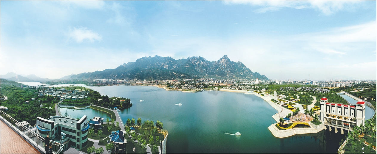
国网新源控股有限公司泰安抽水蓄能电站上水库
