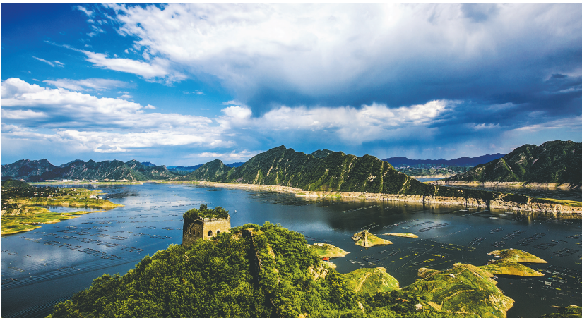
潘家口抽水蓄能电站上水库
