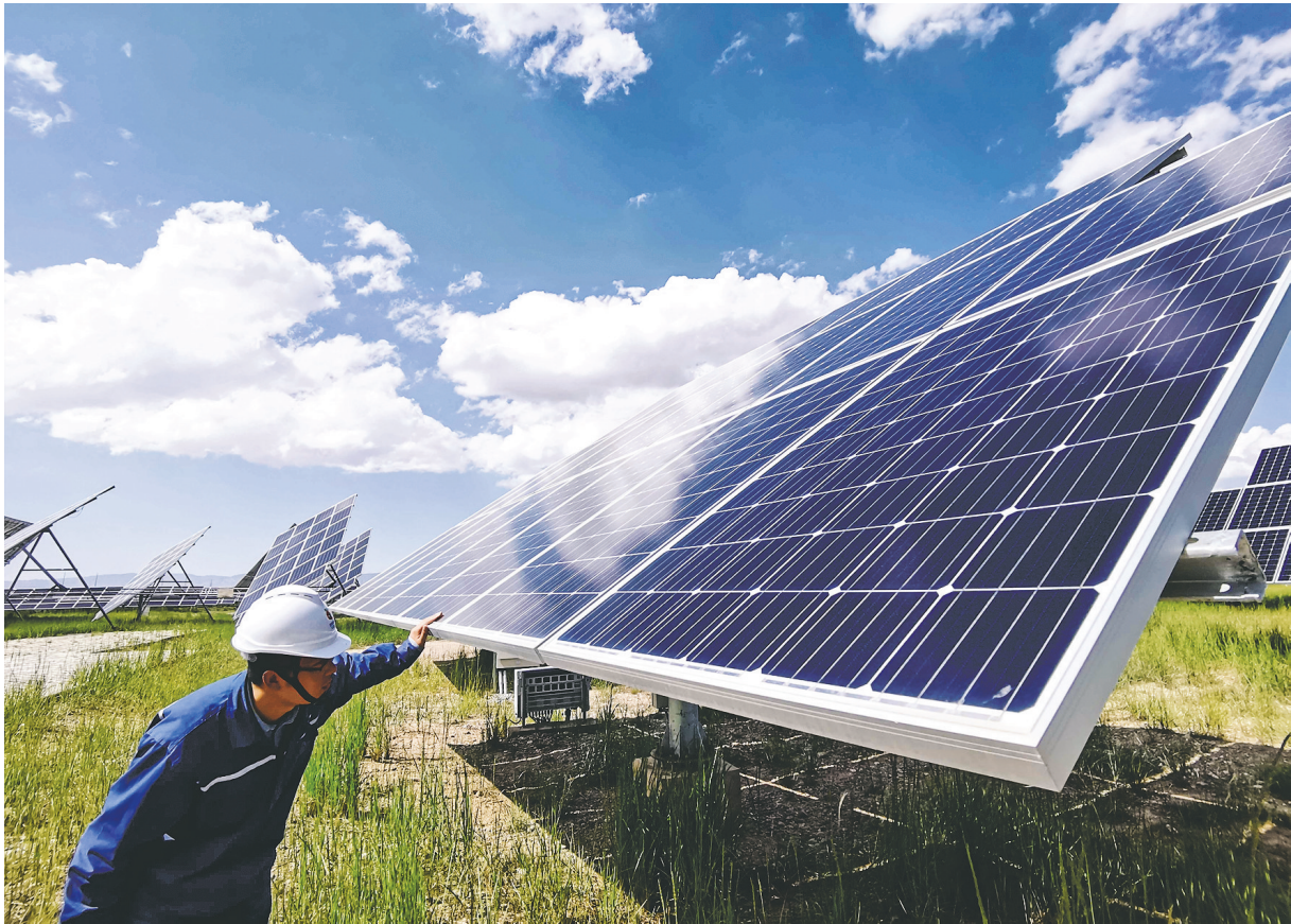
在青海省海南藏族自治州的绿色产业发展园区,光伏电站工作人员查看电池组件。该园区规划总面积为3028.5平方公里,分新能源发电区(光伏发电园、风力发电园)和工业加工制造区,不仅保护了当地脆弱的生态,绿色清洁能源也从园区源源不断向外输送。(资料图片)
