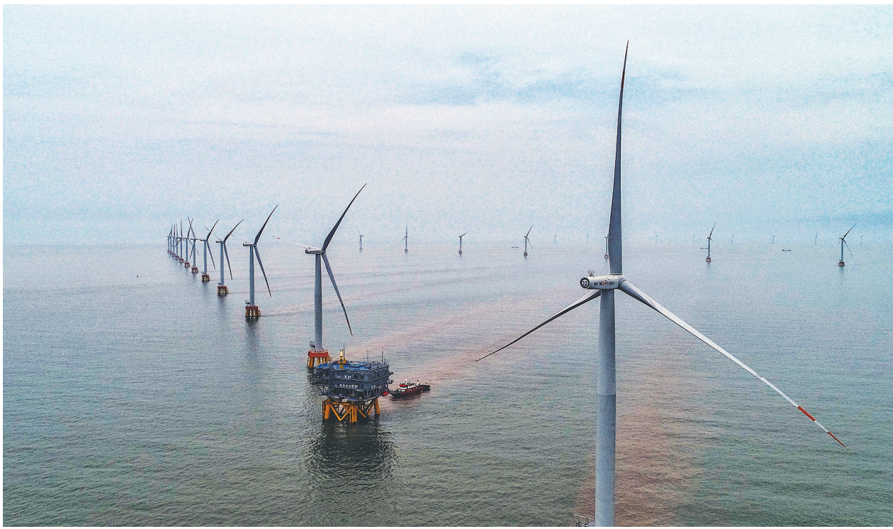
上图:空中俯瞰岱山4号海上风电场(5月16日摄)。近日,位于浙江舟山北部海域的岱山4号海上风电场并网接入工程顺利投运,开始正式并网运行发电。海风“送来”的清洁能源,源源不断供给舟山岛绿色石化基地。浙江省舟山市北部海域的岱山4号、嵛泗5号、6号海上风电场是浙江省最大的海上风电场群。此次正式并网的岱山4号海上风电场共设风力发电机组54台,总装机规模为234兆瓦,每年上网电量可达6.18亿千瓦时。该电量将全部用于浙江舟山绿色石化基地,持续为舟山绿色基地注入绿色动力。(资料图片)
