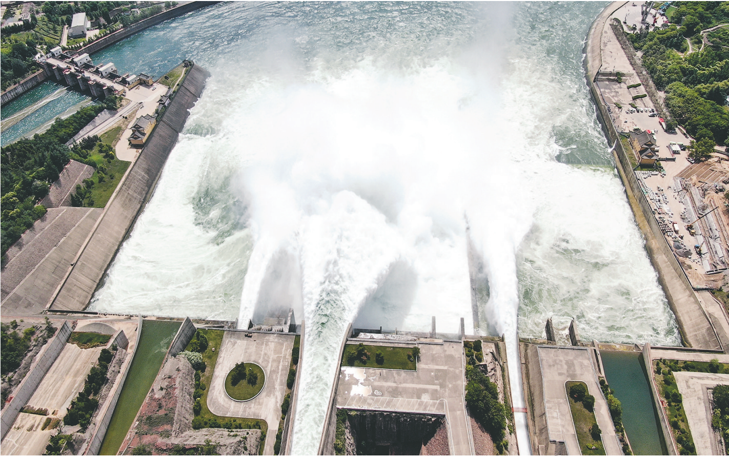
从6月19日9时开始，水利部黄河水利委员会调度万家寨、三门峡、小浪底水库，结合腾库迎汛，实施2021年汛前黄河调水调沙。当天，小浪底水库的流量按照2600立方米每秒下泄。图为黄河小浪底水利枢纽工程。
