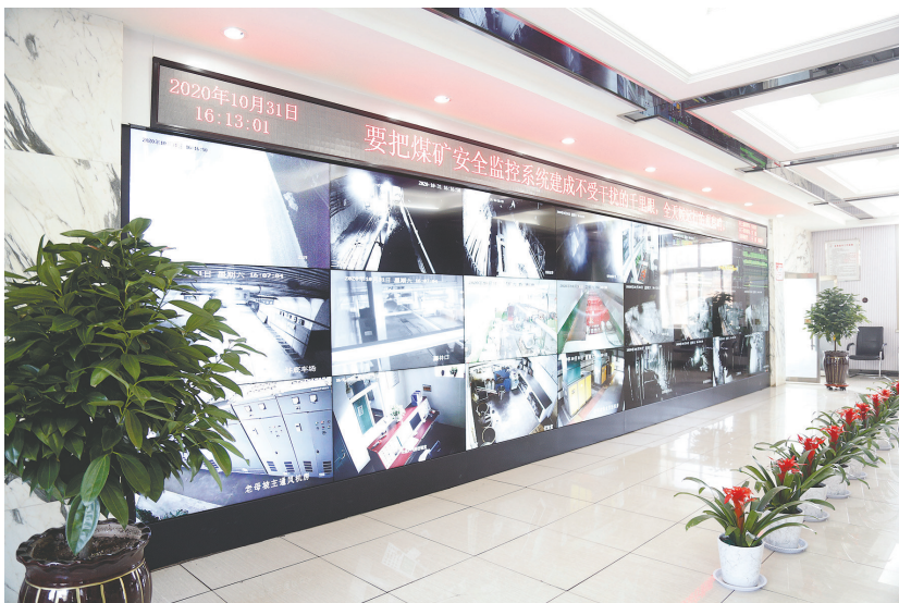
老母坡煤业调度室
