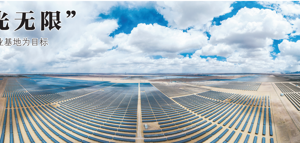
从柴达木盆地到三江源,一座座太阳能光伏电站矗立在高原大地。图为三峡新能源格尔木清能发电有限公司光伏电站。(青海省商务厅供图)
