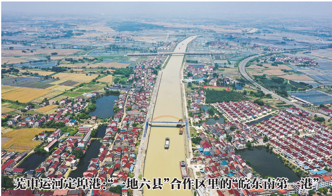
芜申运河定埠港:“一地六县”合作区里的“皖东南第一港” 位于安徽省宣城市郎溪县梅渚镇境内的定埠港,曾经只是个小渡口,如今却成了承担长三角地区“一地六县”企业散货、件杂货、集装箱运输的“中转站”。芜申运河素有“黄金水道”之称,是长三角地区高等级航道网“两纵六横”中的重要“一横”,可常年通行1000吨级~1500吨级船舶,丰水期可通行2000吨级船舶。图为芜申运河定埠港。
