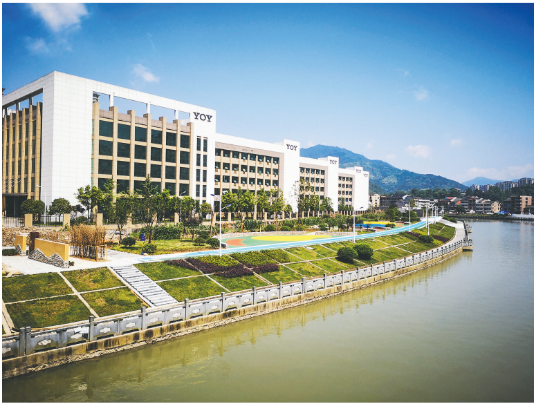
桥下镇垟湾工业区
