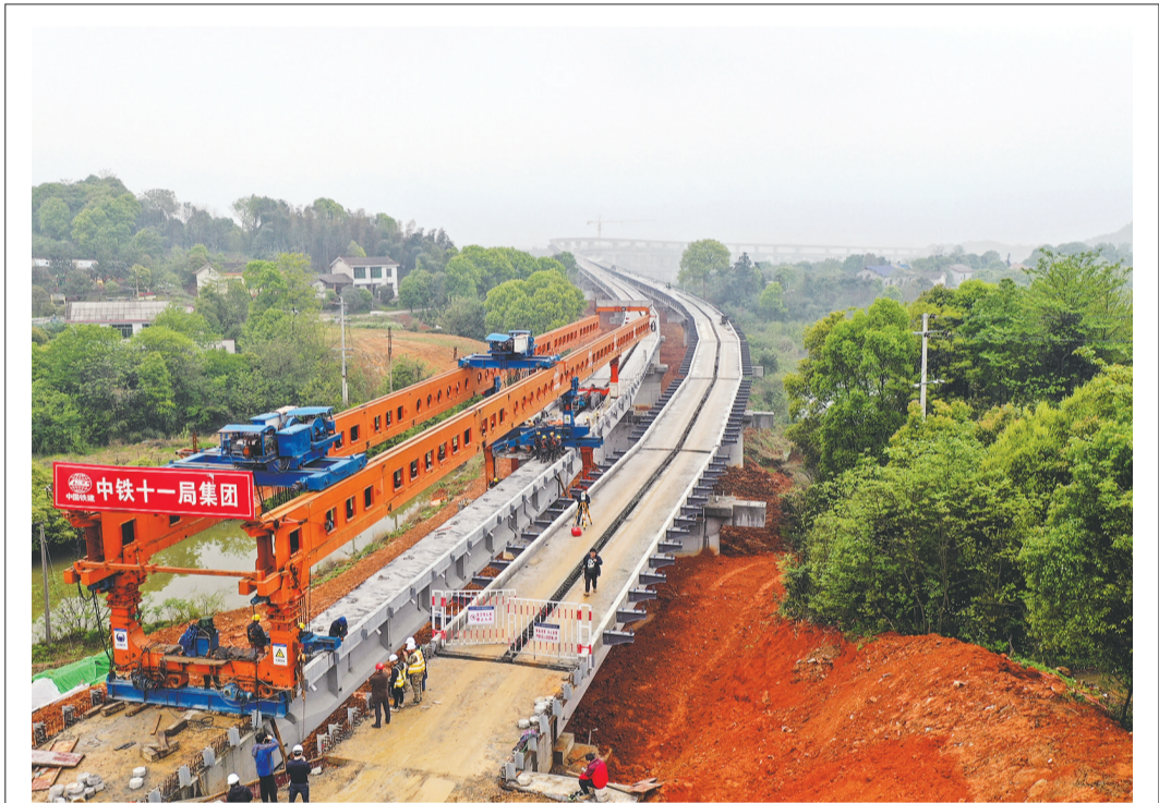
常益长铁路施工忙
