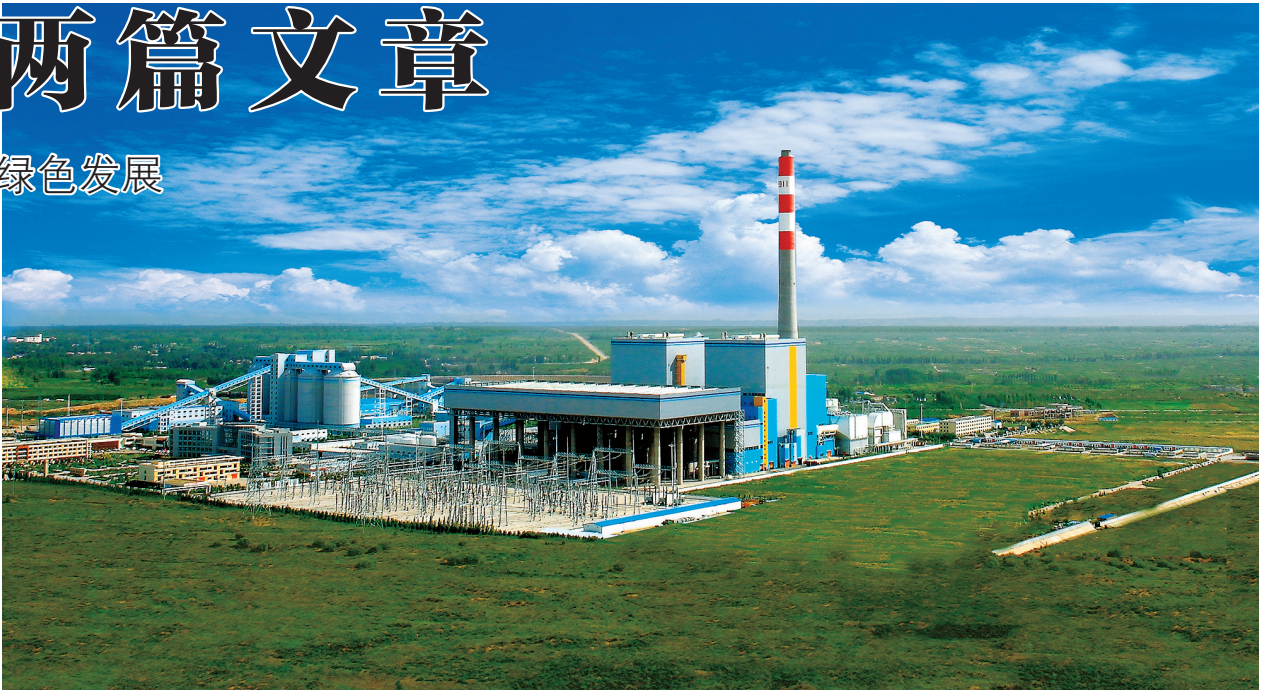
布连电厂完成超低排放改造
