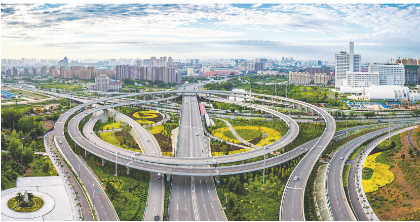
公主府北立交桥
