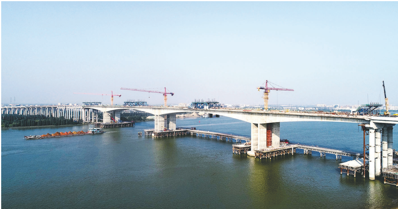
在建的中开高速公路
