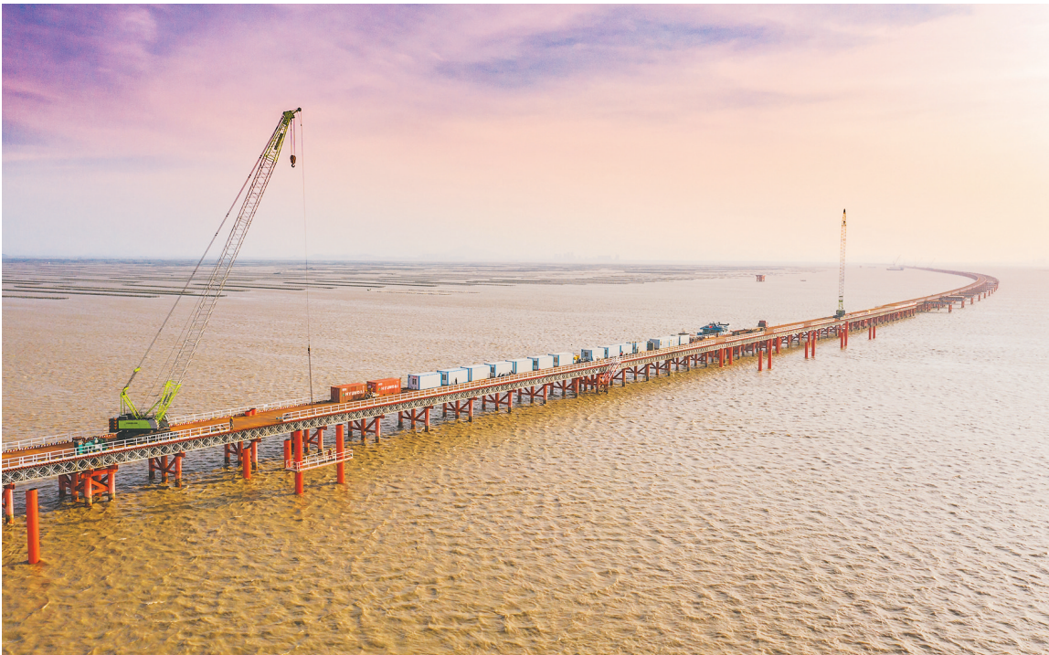
在建的黄茅海大桥
