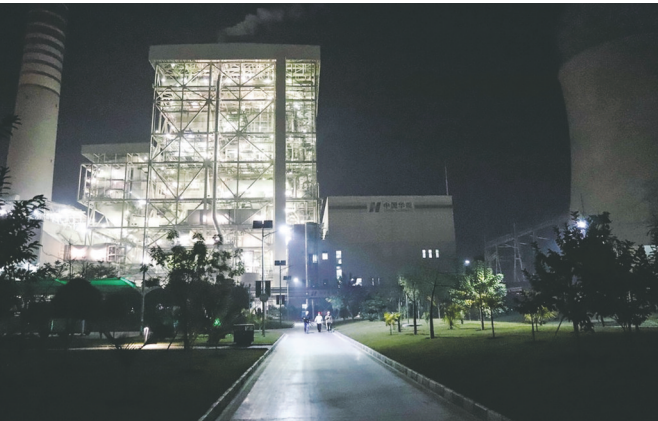
这是1月25日拍摄的巴基斯坦萨希瓦尔燃煤电站
